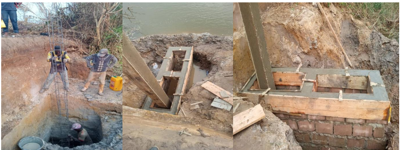
Figure 3. Travaux de construction de la structure et du canal
